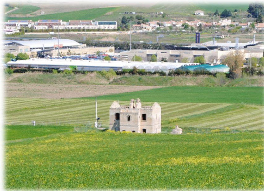
Casello Ferroviario Borgo Venusio, Matera (MT) - Basilicata
